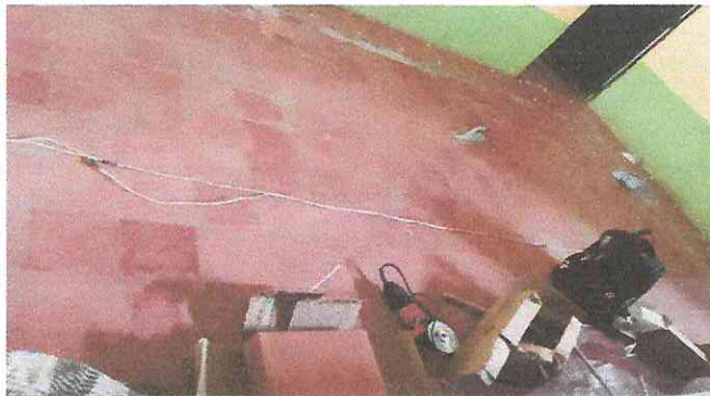
Foto 1: PROCESO DE INSTALACIÓN DE PISO CERAMICO EN AULAS.
