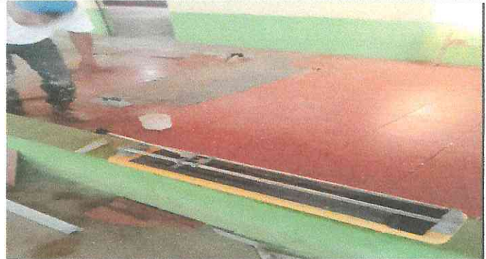
Foto 2: PROCESO DE INSTALACIÓN DE PISO ANTIDESLIZANTE EN CORREDORES.
