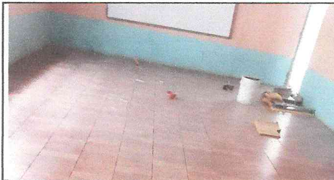
Foto 5: PROCESO DE INSTALACIÓN DE PISO CERAMICO EN AULAS.
