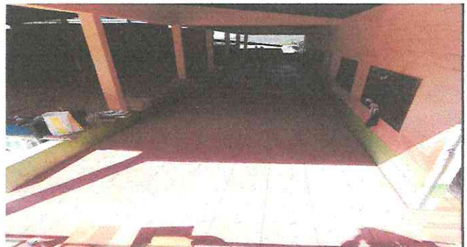
Foto 6: PROCESO DE INSTALACIÓN DE PISO ANTIDESLIZANTE EN CORREDORES.
